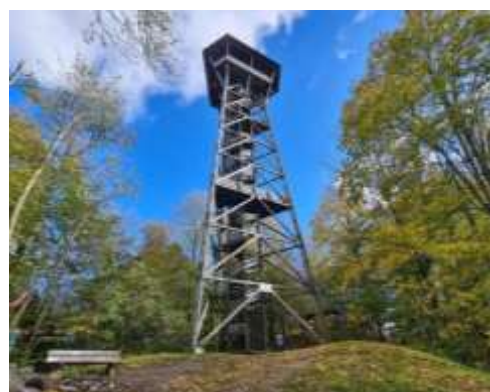
kurze Feier beim Hochwacht-Turm
